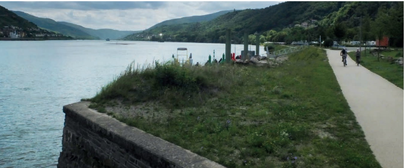
Alte Kaimauer im südlichen Bereich der Rheinanlage
