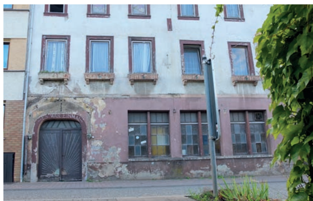
heutiger Zustand des ehemaligen Ausflugslokals (oben) und des Eingangsgebäudes an der B 9 (unten)
