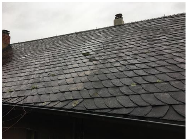
Schiefereindeckung Brgseite von 1950
