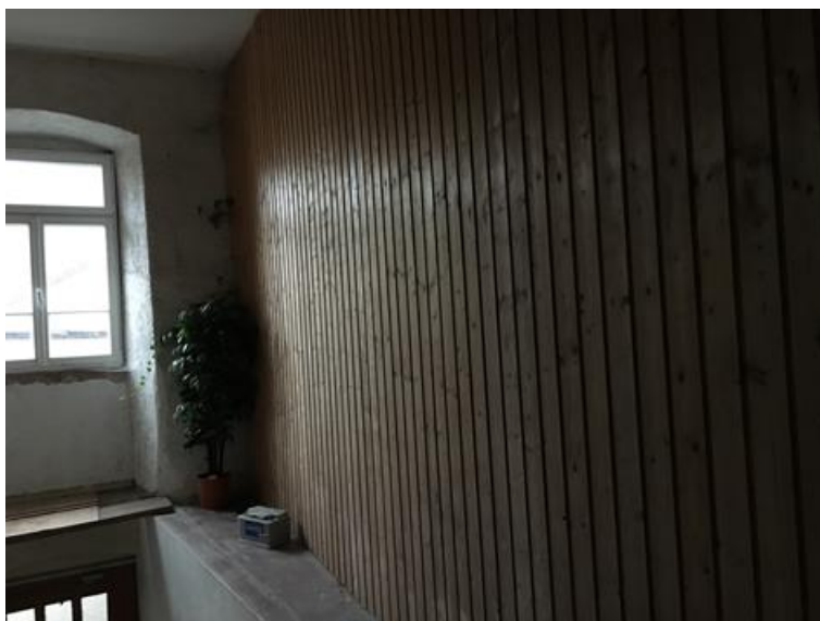
Bergseitige Außenwand im Treppenhaus mit Verkleidung
