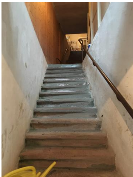
Südliches Treppenhaus ins Dachgeschoss
