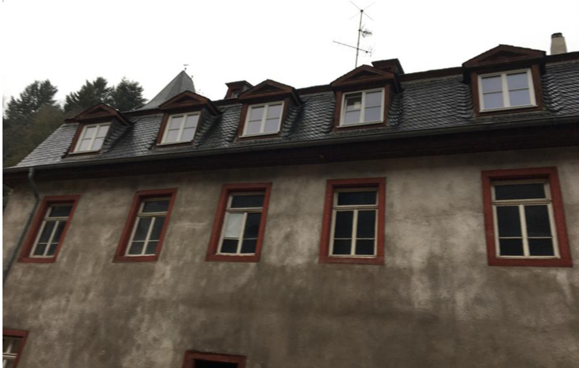
Fassade südlicher Teil
