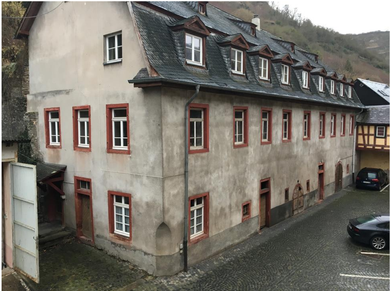
Rathaus Rückgebäude von Süd-Osten (Innenhof Rathaus) Januar 2018
