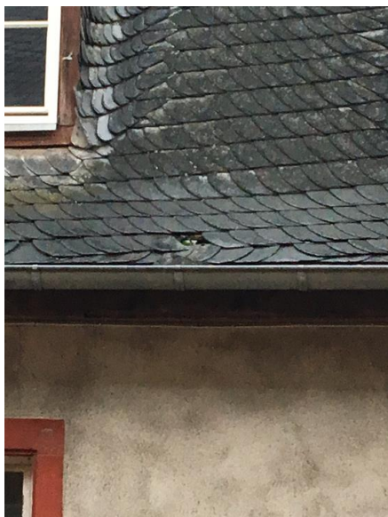
Schäden Dacheindeckung
