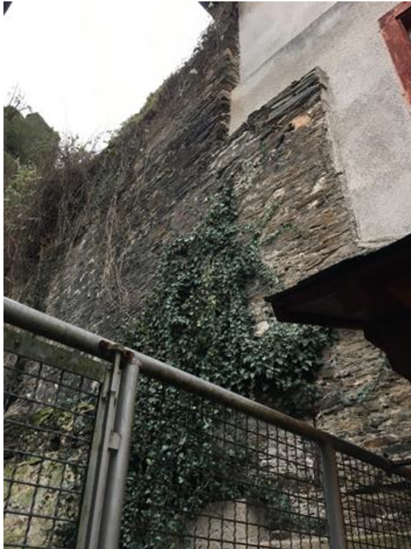
Natursteinmauer zwischen Hang und Gebäude
