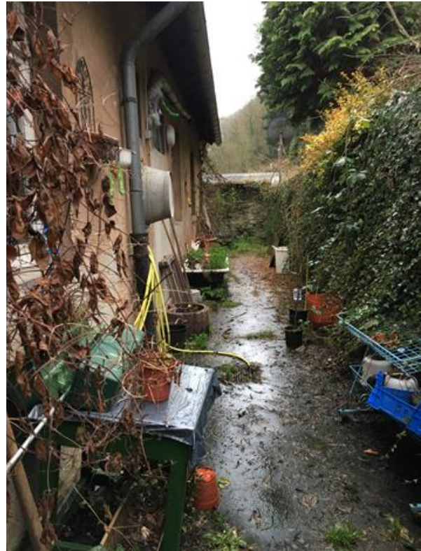
Terrasse im Dachgeschoss zwischen Gebäude und Hang
