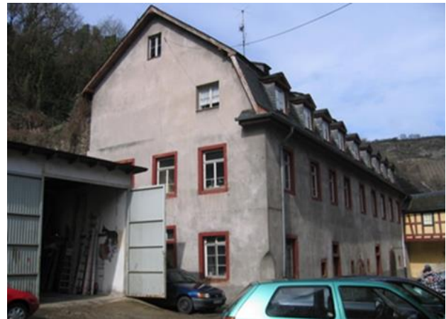
Rückgebäude von Süden mit Mansarddach 2016
