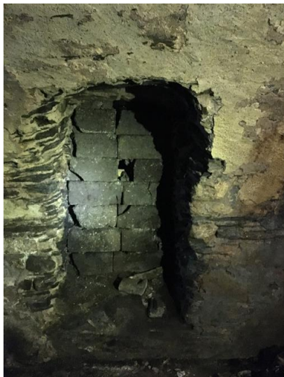
Abmauerung eines Ganges in den Hang
