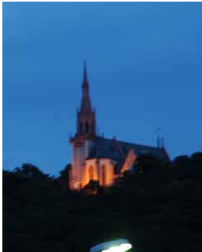
Rochuskapelle, Bingen _ fehlende Turmbeleuchtung
