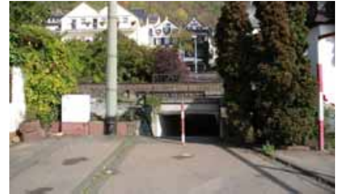
dunkler Eingang in Unterführung
