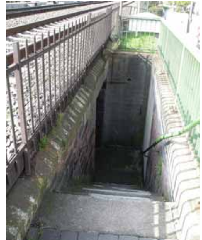
dunkler Eingang in Unterführung
