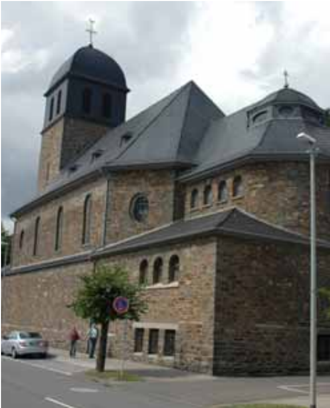
Straßenleuchte im historischen Umfeld
